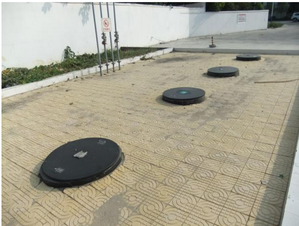
汽油、柴油罐区
